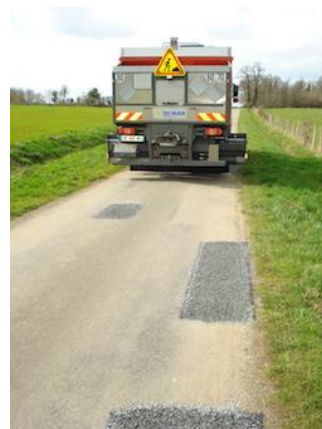
SECMAIR CHIPSEALER CT 360 équipé du système E TRAXX de détectio
